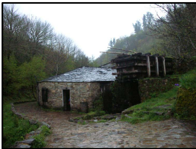
Ilustración 12. Mazo hidráulico de ferrería en Santalla. Fuente: X.V.F.
