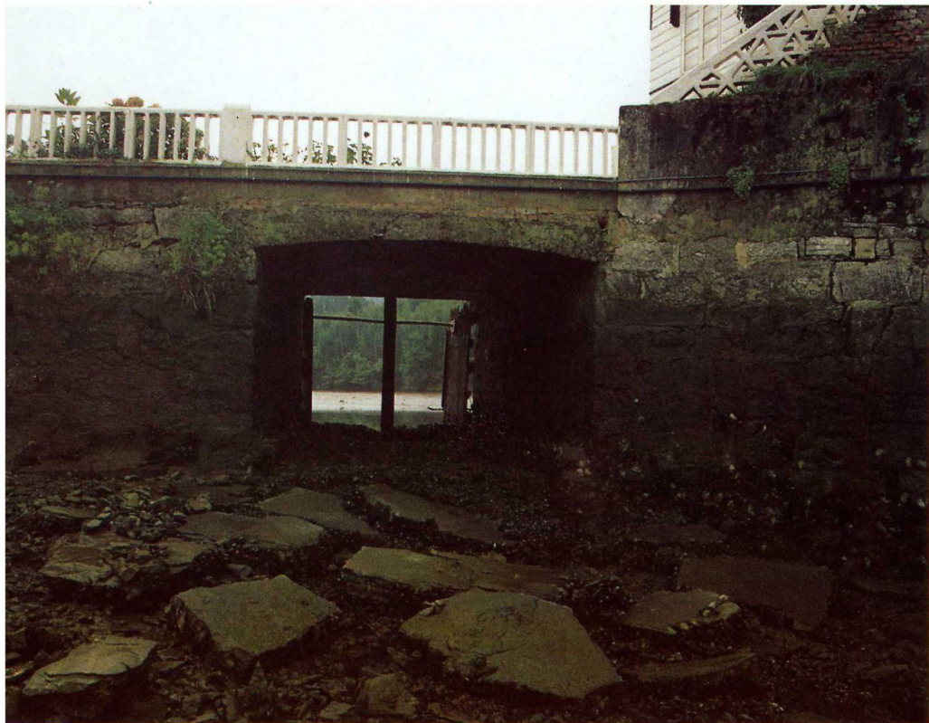
▲ Compuerta de la Enciema de Tornón, vista desde la ría.
