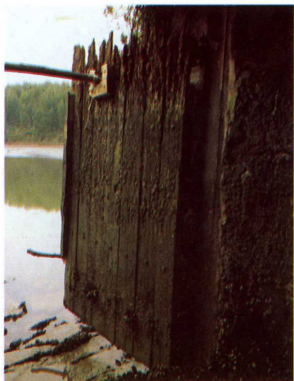
▲ Detalle de la compuerta de la Enciema de Tornón.
