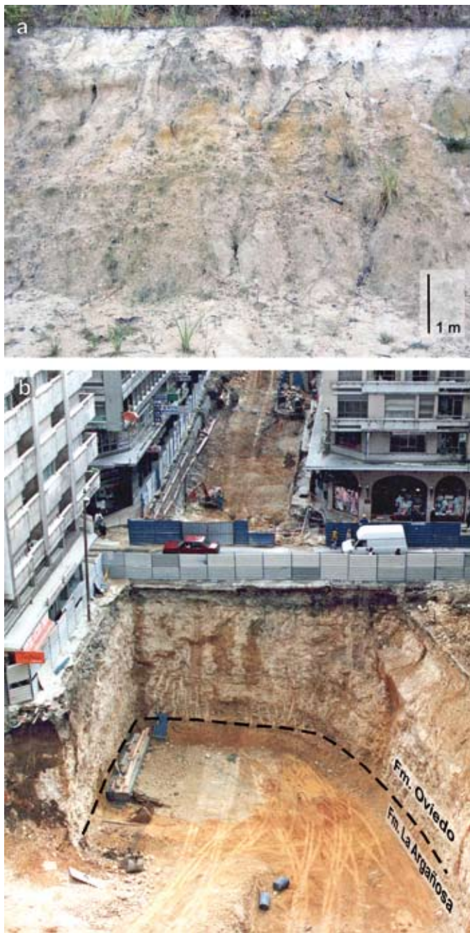
Figura 1. Afloramiento de la Formación La Argañosa en las afueras de Oviedo (a), y excavación de un aparcamiento subterráneo que corta el techo de la unidad (b).
