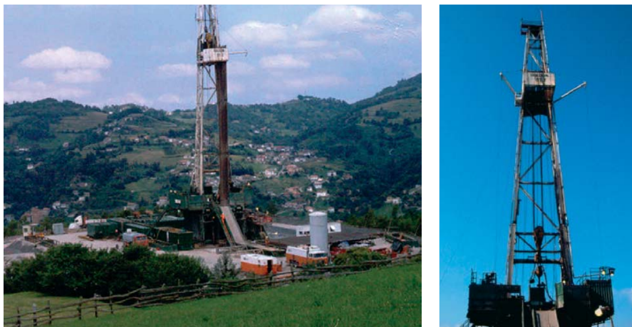
Figura 11. Sondeo “Modesta-1” efectuado por “Unión Texas España” en el sinclinal de Sama para búsqueda de metano. A la derecha, detalle del castillete.
