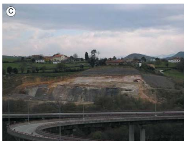
Figura 15. Aspecto de campo de la Formación Latores. A) Antigua explotación de arenas próxima al “Centro Médico” de Oviedo (altura de talud: 15 m aprox.). Los materiales grises del techo ya pertenecen al miembro inferior de la Fm. San Lázaro. B) Arenero en la zona de Cabornio (zona de La Manjoya). C) Arenero en “El Toral” (La Manjoya). Los niveles superiores más oscuros corresponden a la Fm. San Lázaro.
