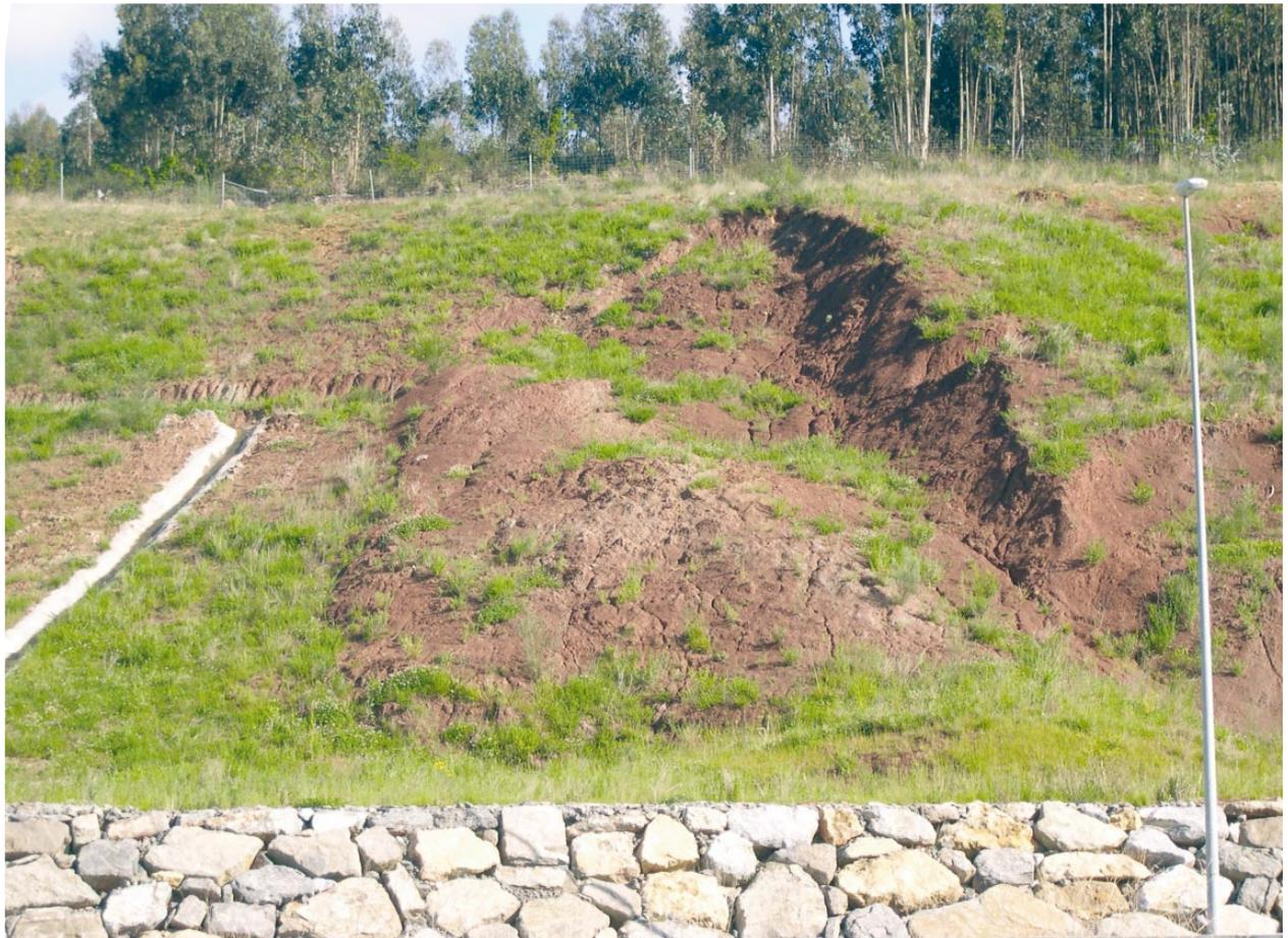
**Figura 7.** Deslizamiento reciente en las proximidades del entronque de la Autovía A-64 y la A-8, donde se aprecian la masa desplazada y la cicatriz erosiva.
