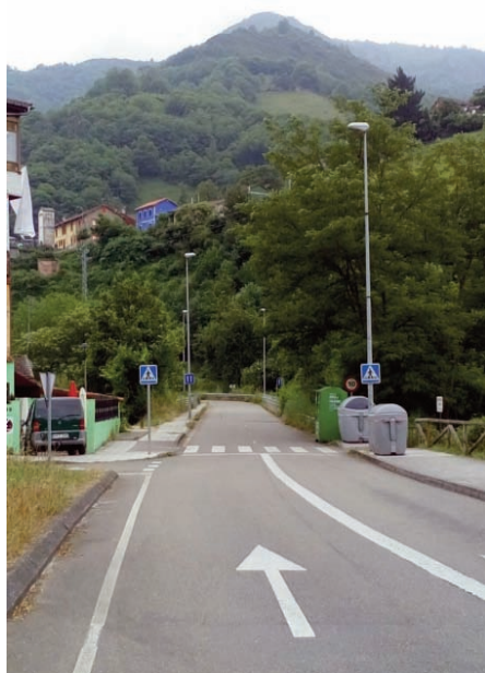
Puente de La Banciella.
