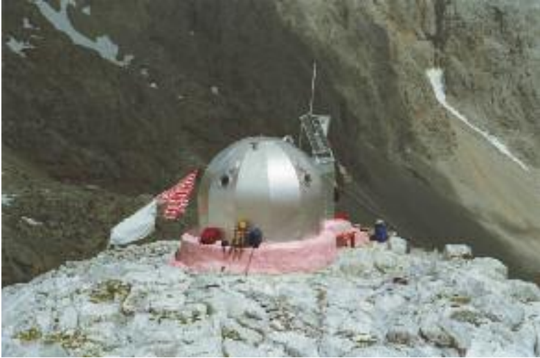
La célèbre Cabaña Verónica (2 325 m), au sud du Naranjo. Inauguré en 1961, ce refuge-bivouac de 9 m 2 de surface a été construit à partir de la coupole d'une batterie antiaérienne du porte-avion américain USS Palau, © D. R.
